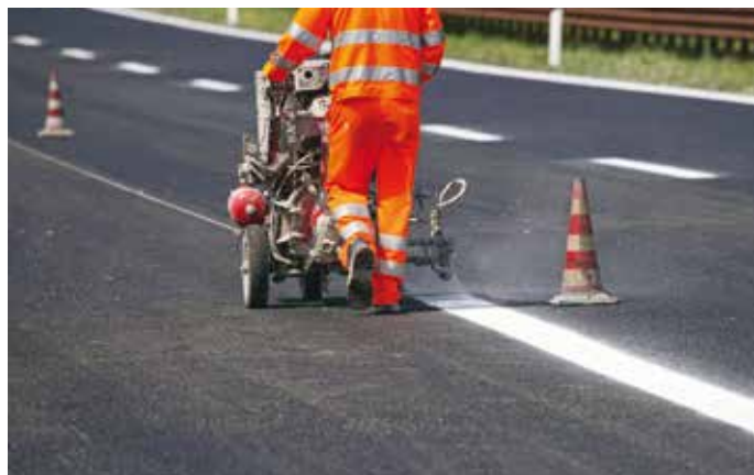
18. Il controllo della temperatura del bitume è fondamentale per la tutela della salute dei lavoratori
