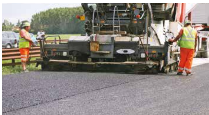
1. L'esposizione valutata su addetti con diversa funzione risulta inferiore durante la posa di asfalti gommati nei siti investigati nel 2014
