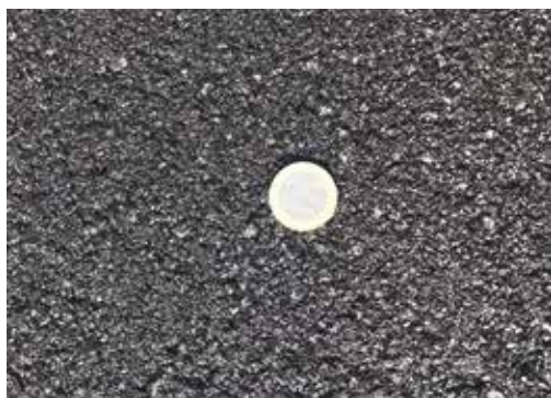
2. Esempio di manto di usura a bassa emissione sonora: la mitigazione del rumore è ottenuta limitando la generazione del rumore di rotolamento
