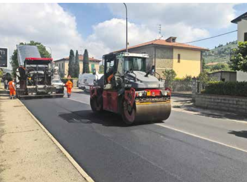
1. Un esempio di tecnologia warm: la stesa delle miscele in assenza di fumi
