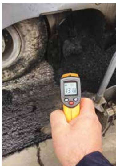
5. Il controllo delle temperature durante la fase di posa in opera delle miscele. Le temperature sono ridotte di almeno 40 °C gradi rispetto alle usuali miscele tradizionali a caldo
