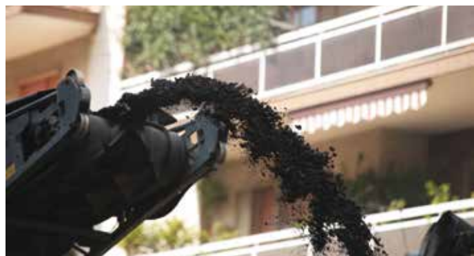
1. Le miscele saranno composte da polverino di gomma riciclata da Pneumatici Fuori Uso e fresato d'asfalto e prodotte con tecnologia a tiepido
