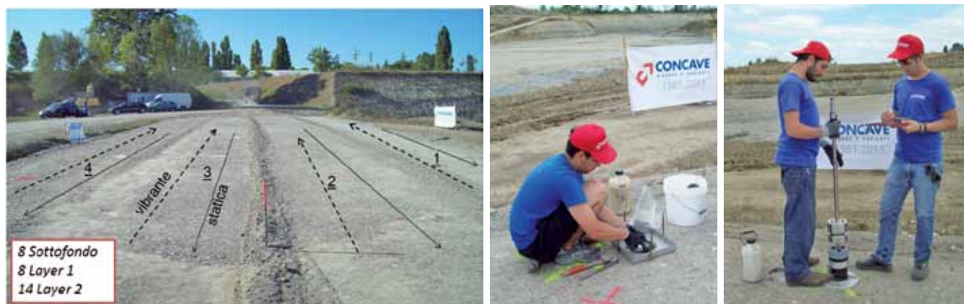
Figura 5 - Schema di compattazione, prove di densità e di portanza con LWD
