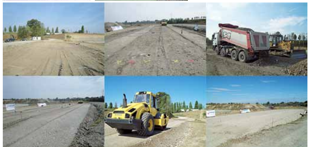
Figura 4 - Fasi realizzative: bonifica, testing, posa del primo strato, compattazione, secondo strato
